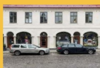
Fasadrenovering på Gräbrodersgatan
