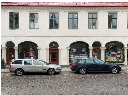
Fasadrenovering på Gråbrödersgatan
